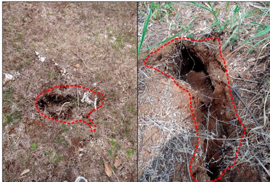
Gambar 11. Rekahan pada permukaan ditengarai sebagai indikasi dan gejala terjadinya proses amblesan
