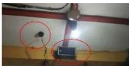
Gambar 15. CCTV Dan Alat Pengeras Suara Ketika Terjadi Keadaan Darurat Pada Pasar Beringharjo
