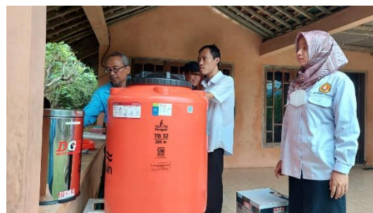
Gambar 3. Pemasangan Alat Pengolahan Mata Air
