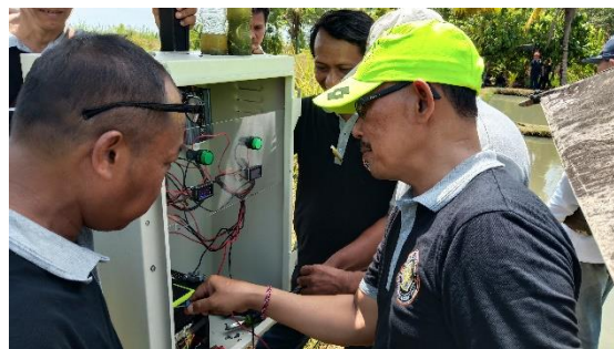
Gambar 1. Pelatihan Teori Pemasangan PLTS
