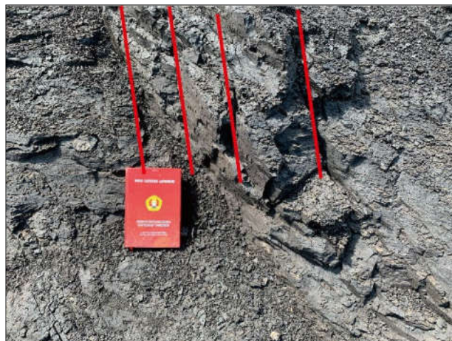
Gambar 5. Singkapan Batubara dengan Struktur Face Cleat Lereng Highwall di LP 42
