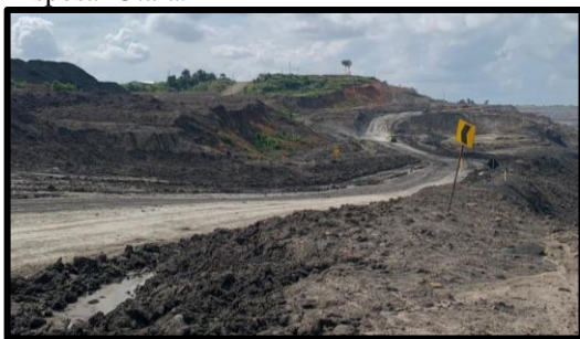
.Gambar 6 Kondisi Jalan Angkut
