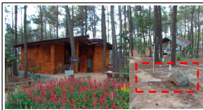
Gambar 2. Kondisi Toilet dan Saptictank di Dalam Kawasan Puncak Becici (Sumber: Penulis)
