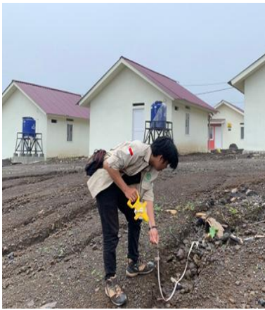
Gambar 1. Kondisi Huntap yang telah dibangun
