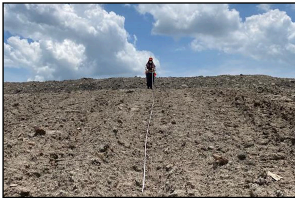
Gambar 5. Kondisi Aktual Disposal Timuer sebelum Perbaikan Geometri
