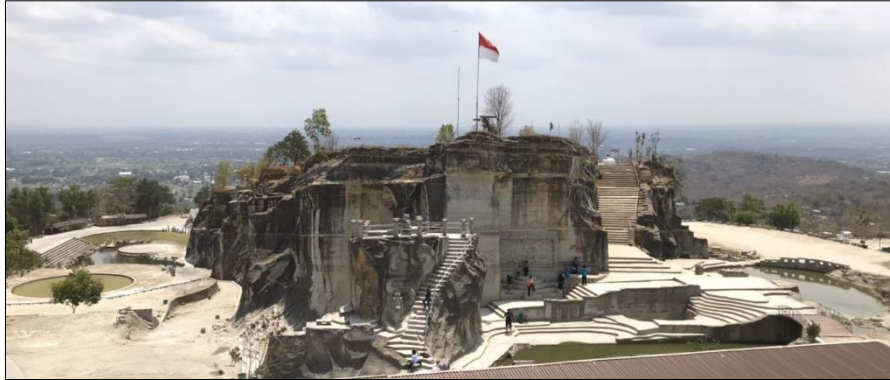
Gambar 3. Kondisi Eksisting Geowisata Tebing Breksi Sumber: Penulis (2020)
