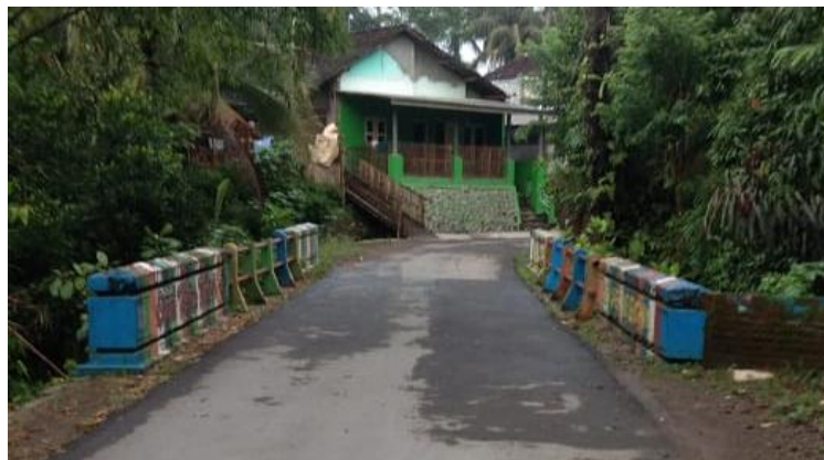
Gambar 13. Gambar Kondisi Jembatan Kali Longkrang Tonjong
