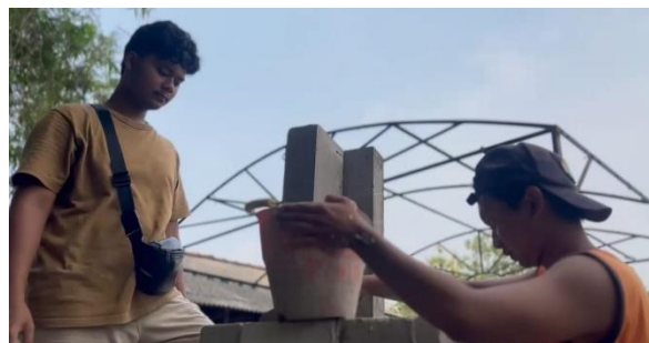
Gambar 4. Pemasangan Cerobong Incinerator
