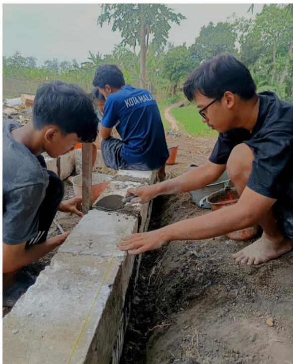
Gambar 3. Pembangunan Pondasi Incinerator
