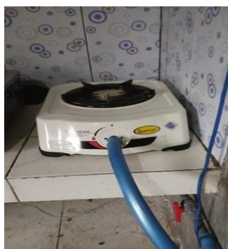
Gambar 6. Penyambungan pipa biogas ke kompor
