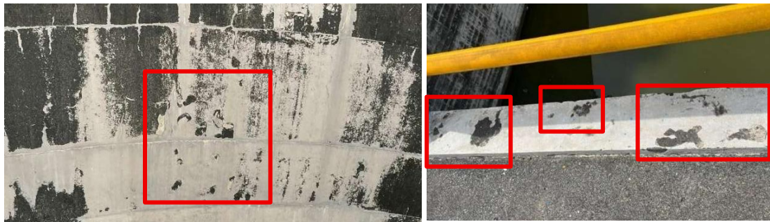
Gambar 8. Pengelupasan ( spalling )
