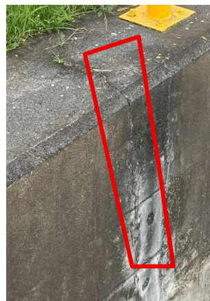
Gambar 9. Retakan ( Cracks ) pada DPT Sisi Selatan Spillway
