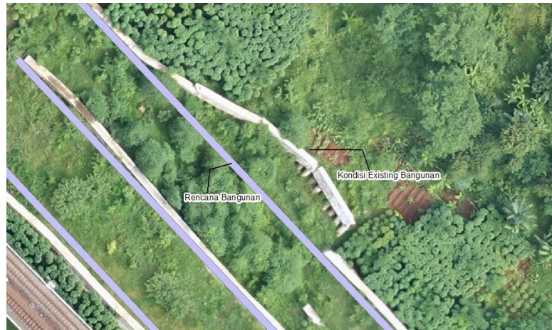
Gambar 11. Kondisi Eksisting Bangunan Penahan Gerakan Tanah
