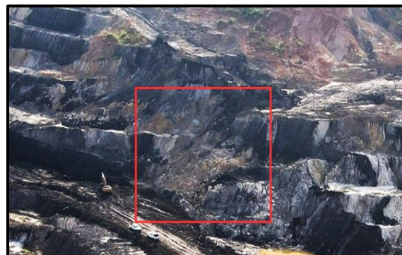
Gambar 4. Kondisi Lereng Longsor
