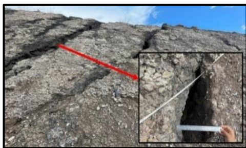
Gambar 12. Crack pada face lereng
