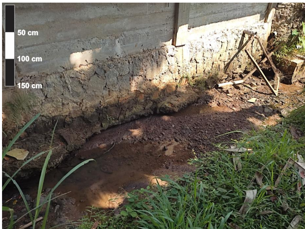
Gambar 8. Erosi pada Fondasi Kolam Renang.
