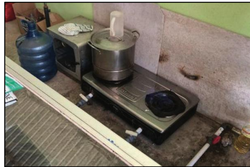
Gambar 5. Penggunaan Biogas Skala Rumah Tangga Sumber: BRIN (2022)
