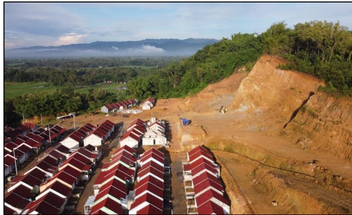
Gambar 7. Kondisi Lereng pada Kawasan Perumahan
